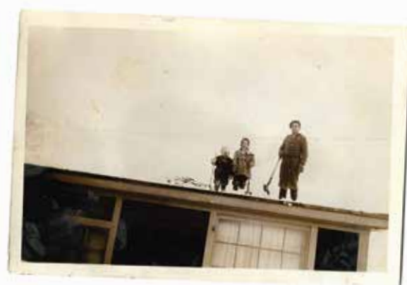
Snømåking på taket til Funkis
